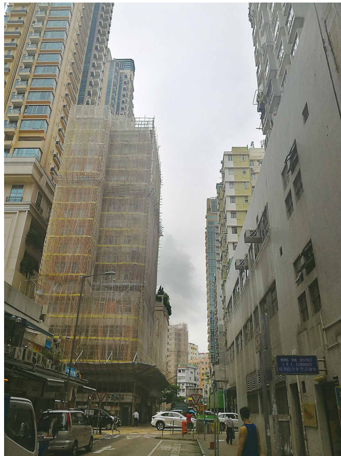
图 6：维修楼宇用的双行竹棚架
