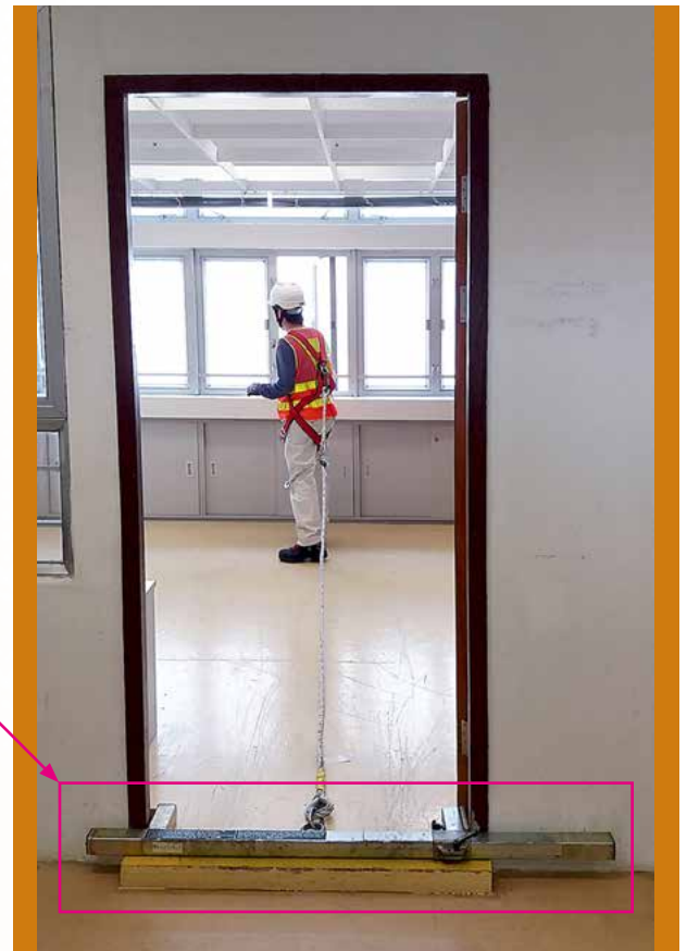
圖 9 – 流動式臨時防墮繫穩裝置的例子
