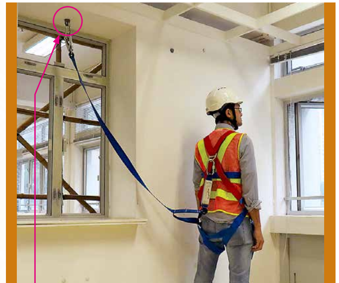
圖 7 - 工人使用有眼螺栓時的情況
