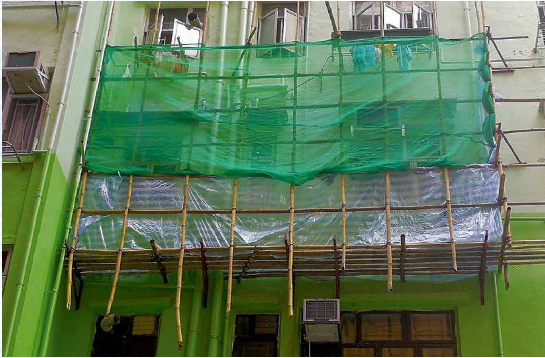
圖 1 - 一般懸空式竹棚架
