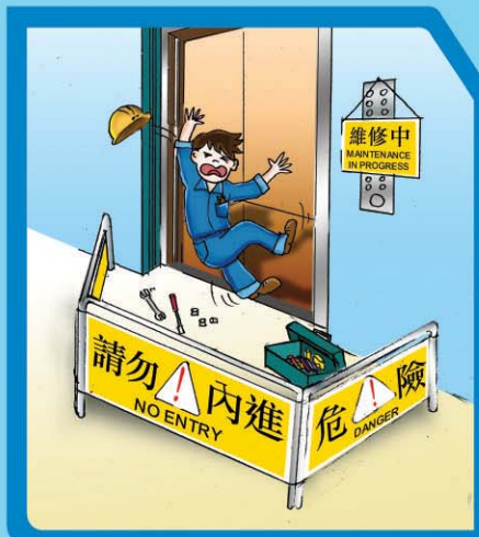
從打開的外門跌落升降機槽內
