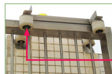
檢查閘門的導輪及滾軸的磨損程度
