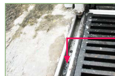
檢查閘門地面軌道的情況及平直程度， 並清除積聚在軌道內的雜物，以免對閘門造成震盪或阻礙其正常運作
