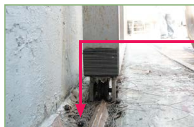
雜物積聚在閘門地面的軌道內，阻礙閘門正常的運作，並可能引致出軌
