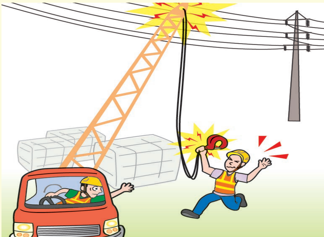
沒有設置屏障及「龍門柱」或其他機械裝置，以限制吊臂活動範圍，防止吊臂觸及架空電纜
