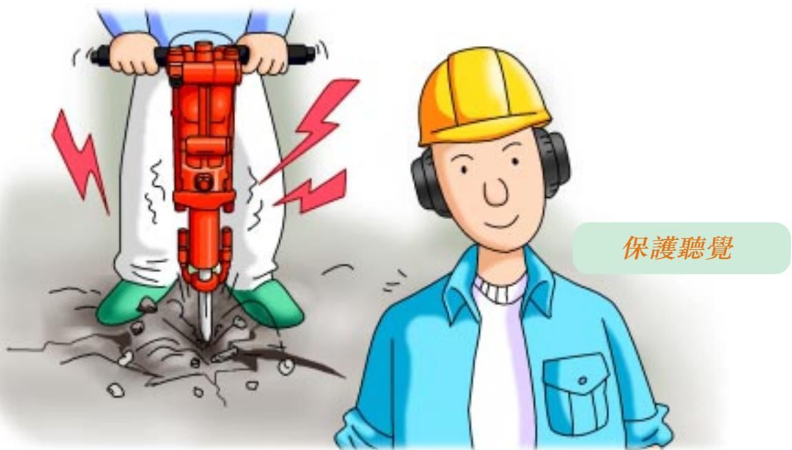
噪音的來源有多方面，例如來自槌擊、拉鋸、五金工作和木工機器等。保養不良的設備亦是噪音的主要來源，例如：壓縮氣體從小孔噴出，蒸氣洩漏，爆裂了（失效）的隔音設備。為了防止噪音對聽覺有不良影響，應注意以下各點：
