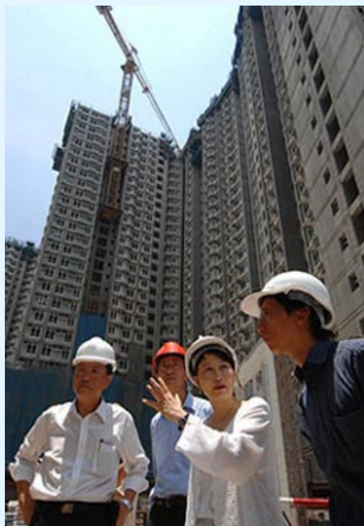
勞工處處長謝凌潔貞巡視建築地盤，對塔式起重機的運作及安全措施表示關注。
