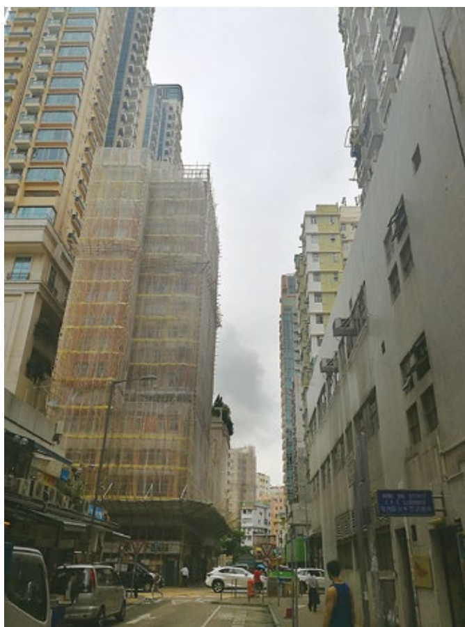
圖 6：維修樓宇用的雙行竹棚架
