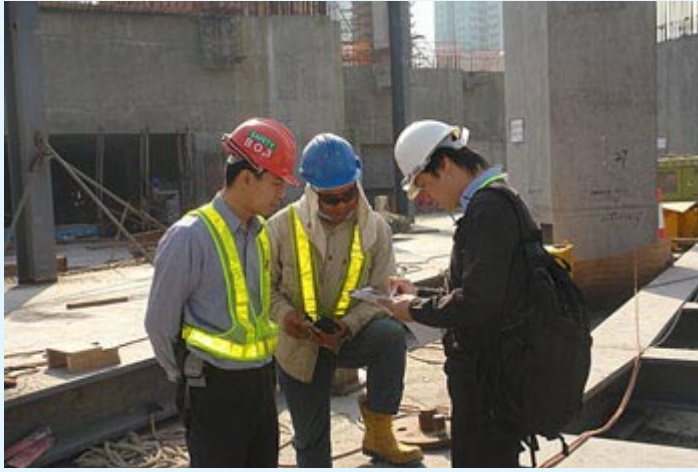
職業安全主任正巡查一建築地盤。
