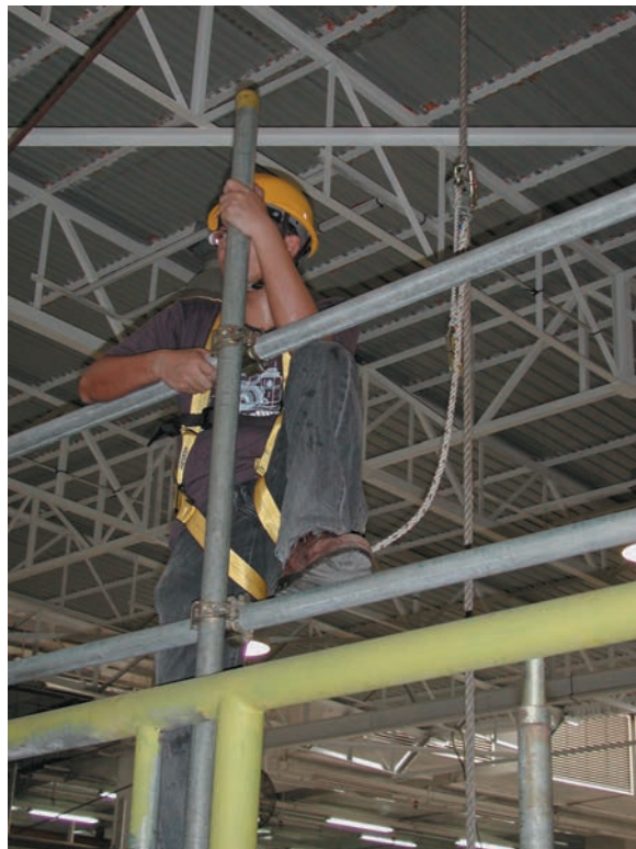
Photo 5 - metal scaffolding e r e c t i o n / d i s m a n t l i n g u s i n g r o p e c h u c k a n d v e r t i c a l i n d e p e n d e n t l i f e l i n e
