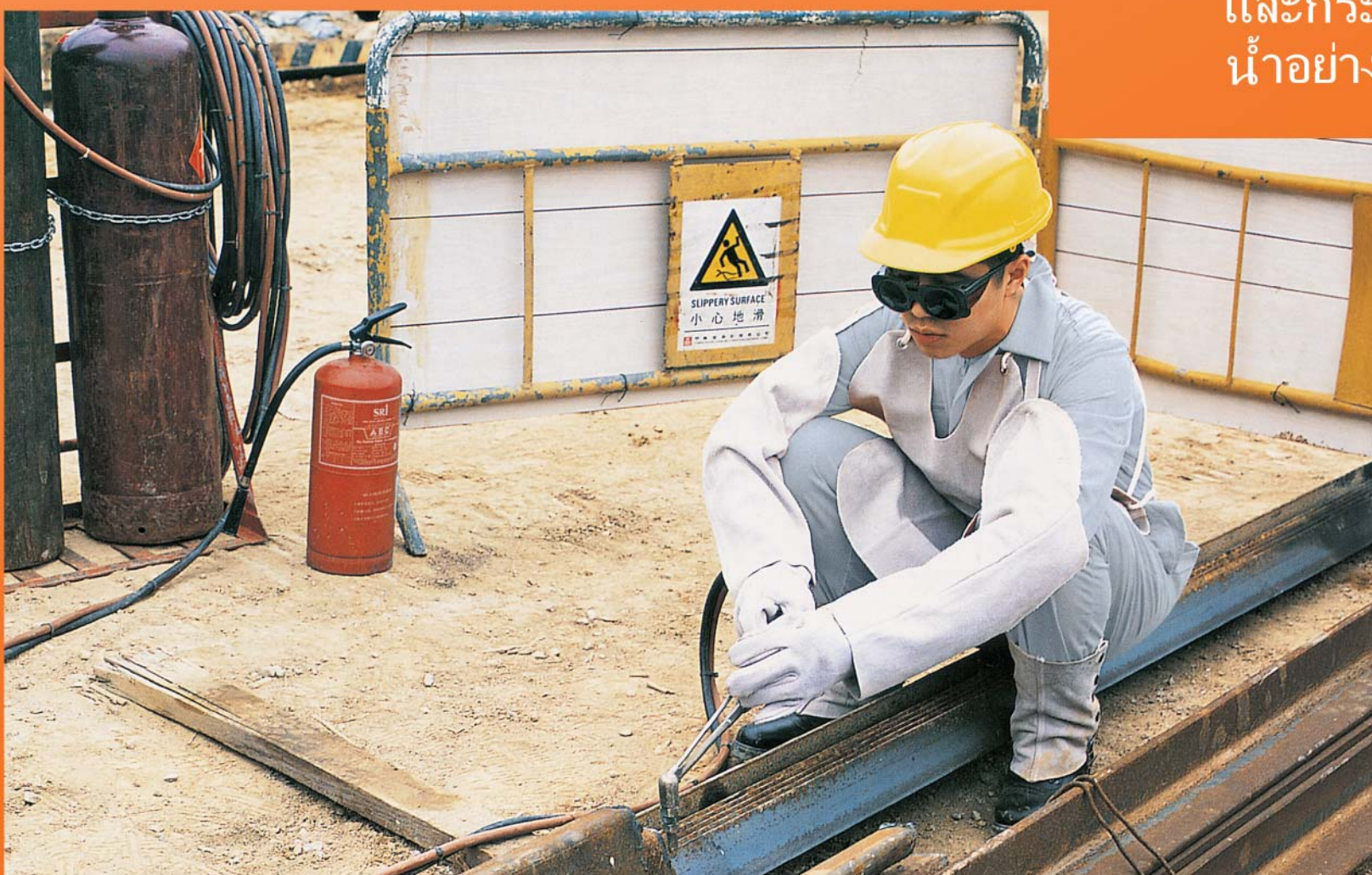
ควรจัดตารางเวลาการทำงานในช่วงที่แดดอ่อนและมีอุณหภูมิต่ำ
