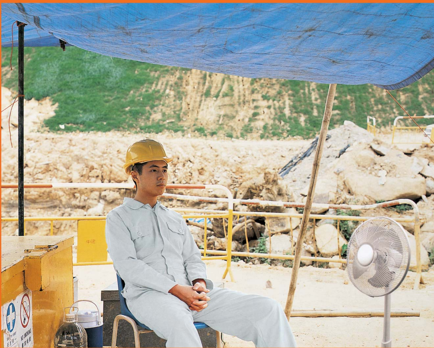
จัดให้คนงานได้พักผ่อนอย่างเป็นเวลาในสถานที่ที่อากาศเย็นสบายและอากาศถ่ายเทดี
