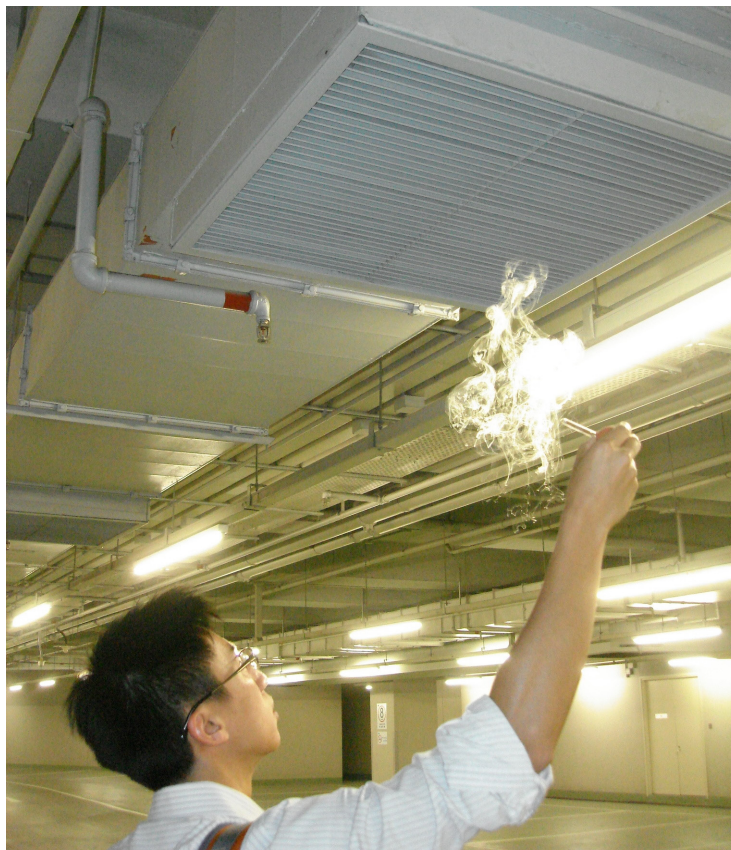
職業環境衛生師利用煙管測試停車場的通風系統
