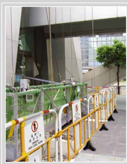
以混凝土压重物把为在吊船 工作的工人而设的独立救生绳 下端固定在地面
