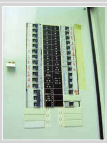
配电箱内的微型断路器（俗称「MCB」）和电流式漏电断路器（俗称「水气掣」）
