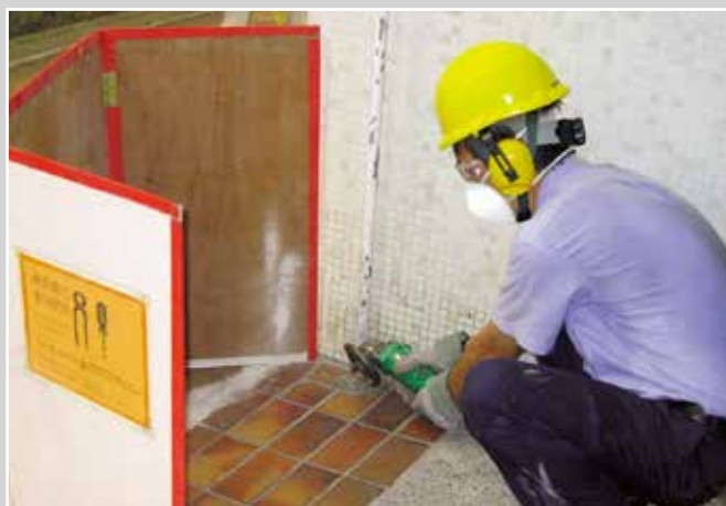
顾及他人的安全，在分隔位置使用手提电动工具
