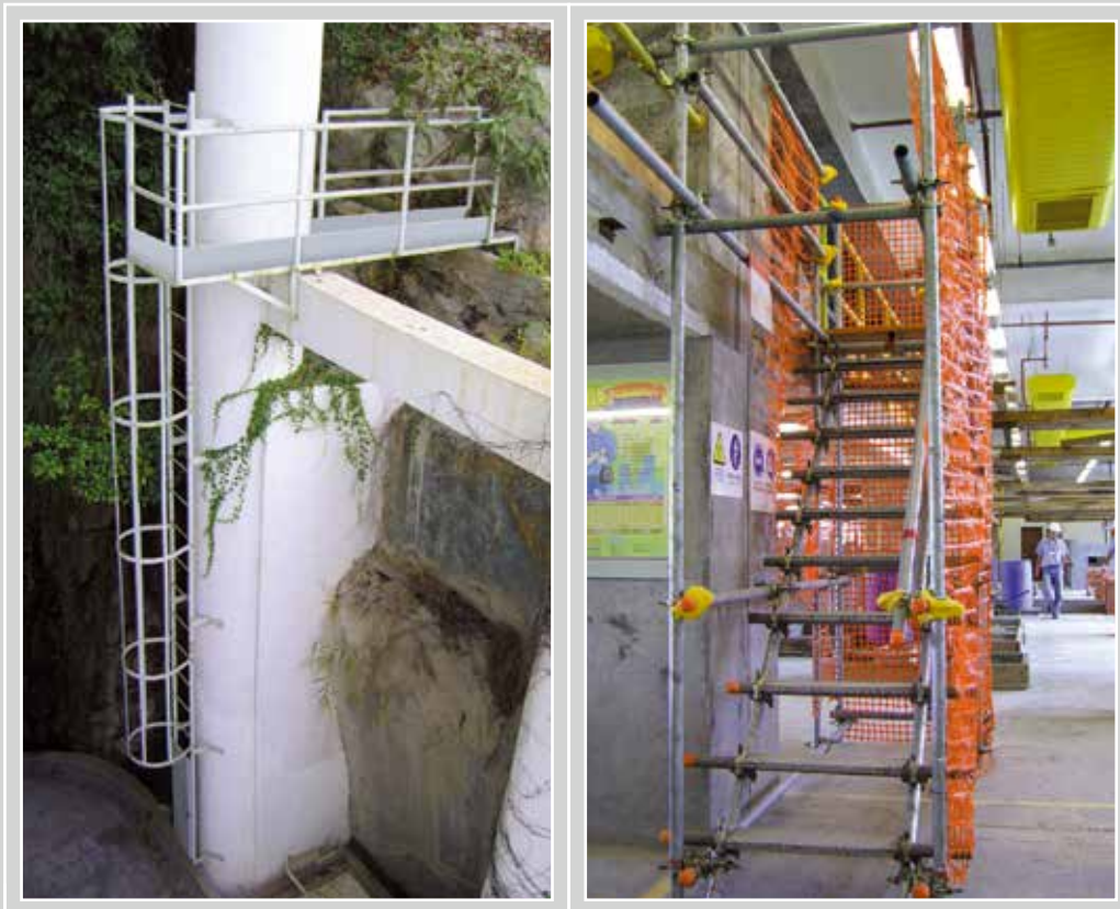
安全稳固的竖梯和临时棚架上落处
