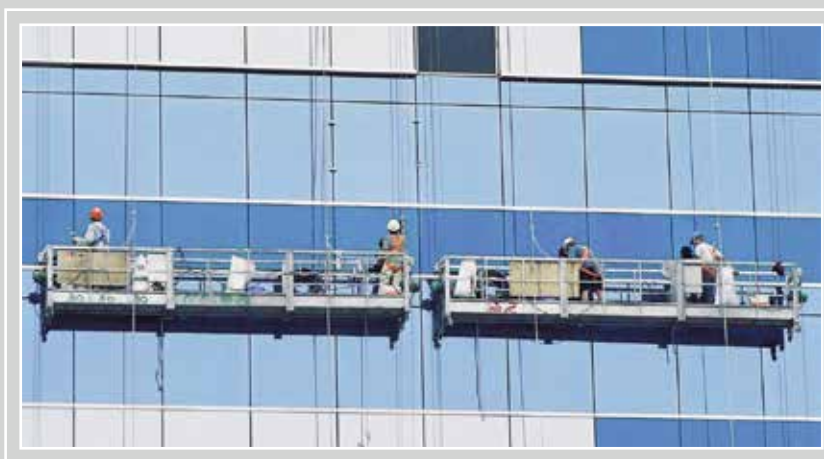
工人在吊船 维修 / 清洁 幕墙
