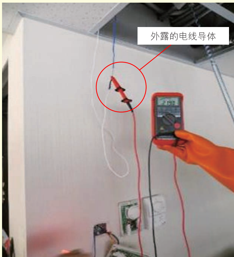
工人有机会触及外露的电线导体
