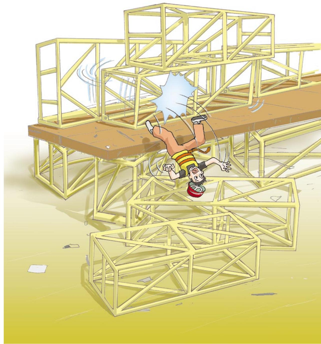
**工人在存货场进行吊运工作时，被移位的塔式起重机悬臂组件撞倒。**
