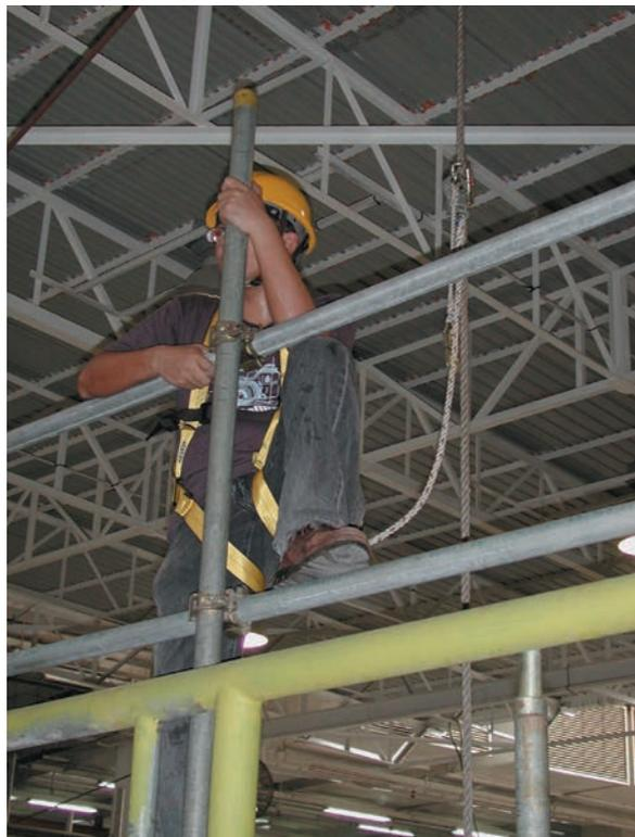
照片五：使用绳索夹头及垂直独立救生绳进行金属架搭建或拆卸工作
