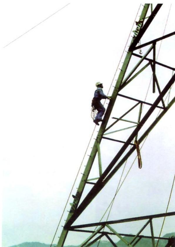
照片六：使用导索、绳索抓钩及绳索调节器进行电塔装嵌工程
