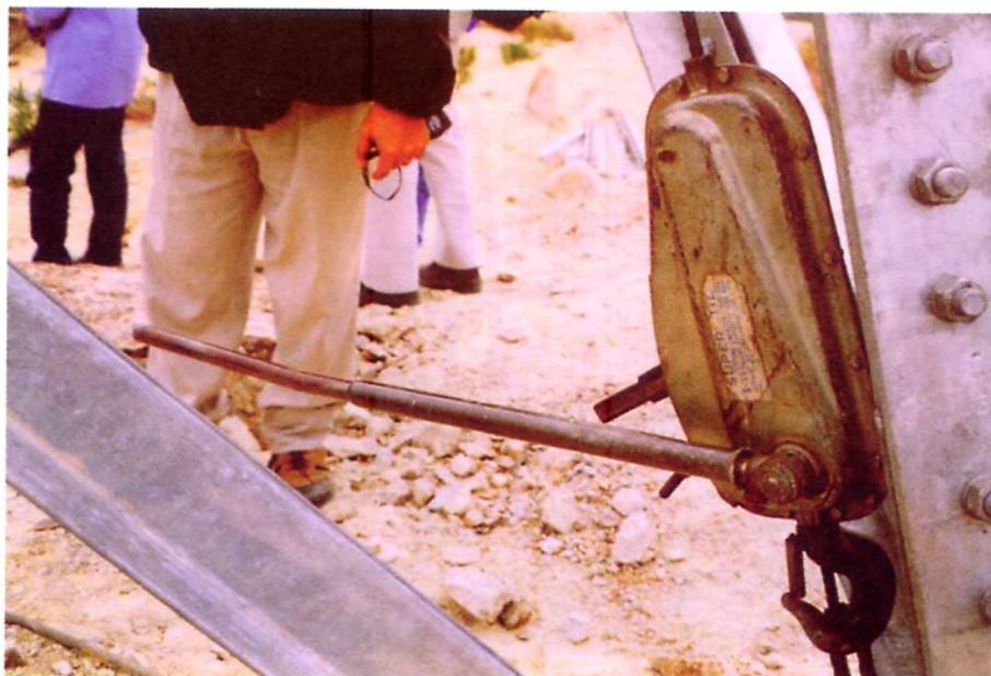
照片七：用以拉紧导索的拉力调节器
