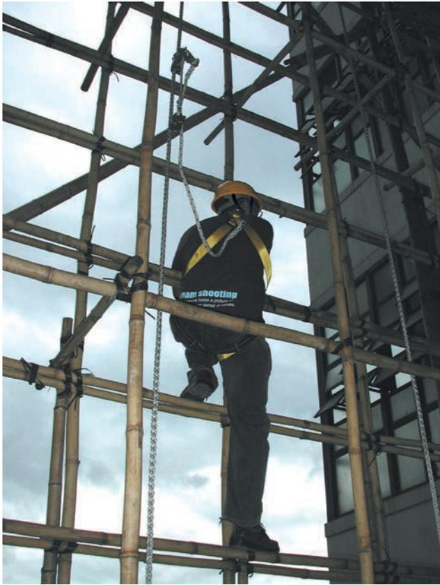
照片四：使用绳索夹头及垂直独立救生绳进行竹棚架搭建或拆卸工作
