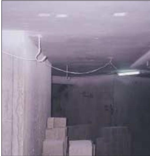
将电线挂起或系好，避免电线磨损及绊倒工人。
