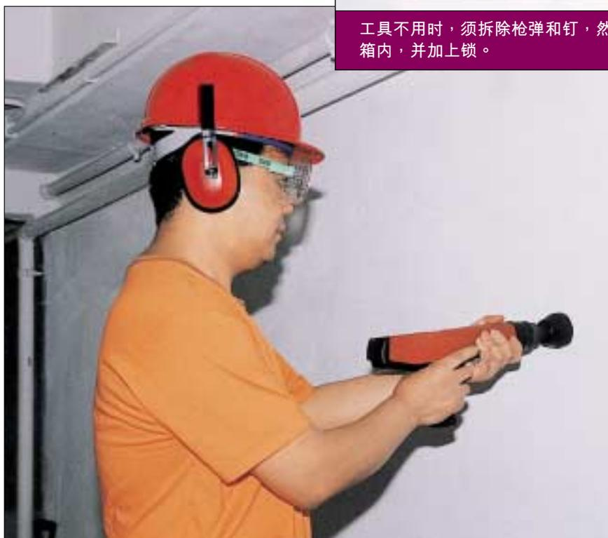
操作员须配戴适当的个人防护装备(包括安全帽、护眼罩和听觉保护器)。
