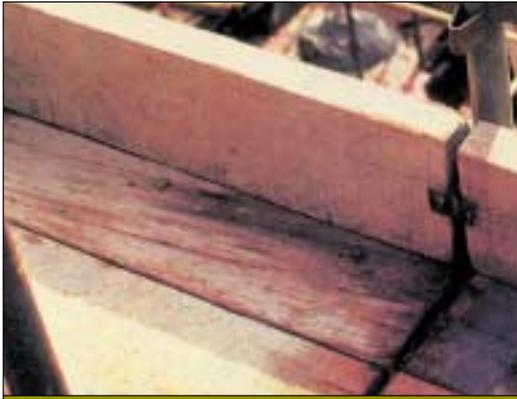
双行金属棚架的工作平台应设有护栏、底护板及以木板铺密\*。
