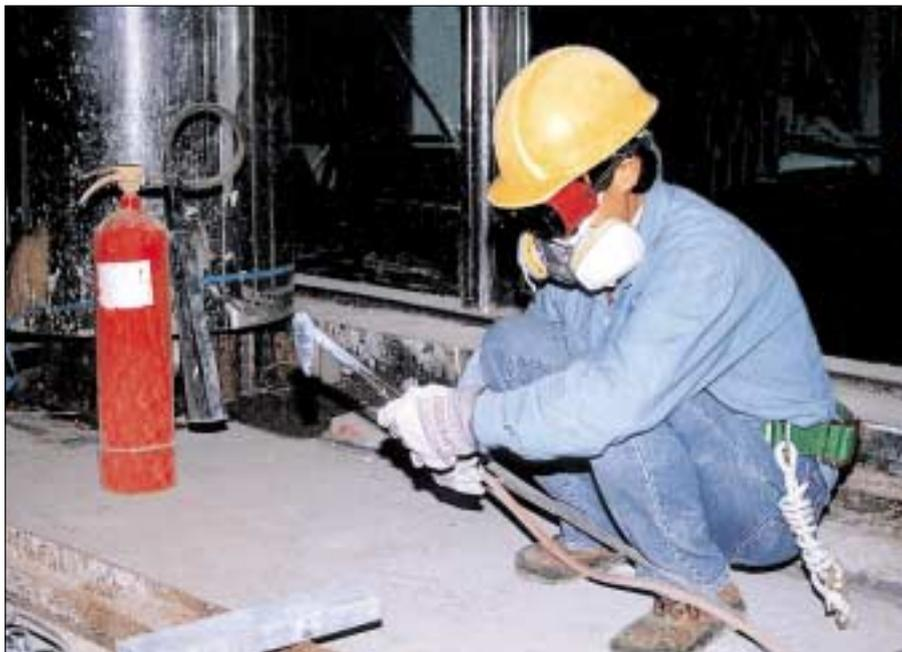
烧焊工序应在空气流通的地方进行，工人须曾接受安全训练，并配戴合适的个人防护装备。
