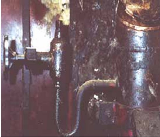
照片22.1 连接压力计（已拆除作调查用） 的接驳处
