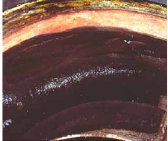
照片22.2 热油炉外壳的贯通裂缝
