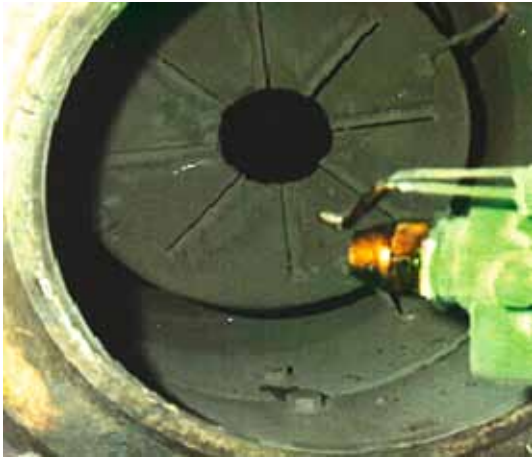
照片23.3 空气扩散器和湿润的燃烧器嘴
