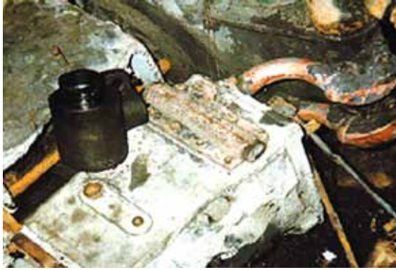
照片4.1 烧毁的燃烧器装置
