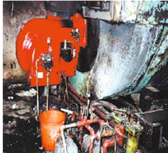
照片5.2 锅炉及燃油系统的损毁情况
