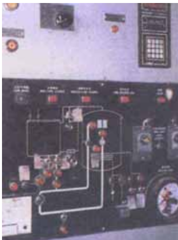
照片6.7 备有刻度盘温度计的控制板(设定温度为摄氏92度)
