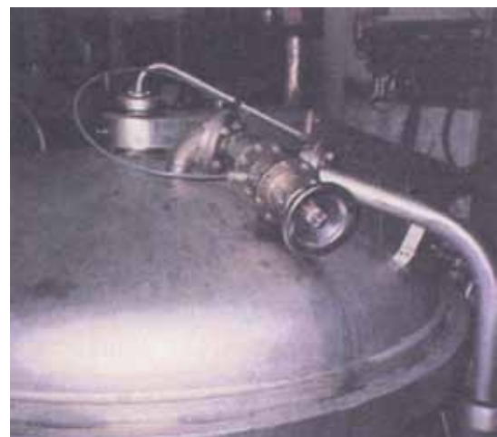
照片6.5 缸盖上的气动溢流阀
