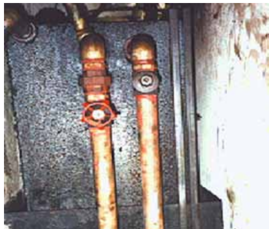
照片23.6 燃油缸、供应燃油管 和回流燃油管
