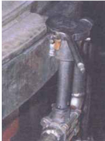
照片6.2 联锁排气阀在关闭的位置上
