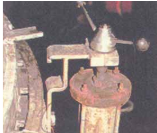
照片13.4 没有联锁装置的溢流阀
