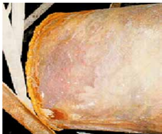
照片7.6 蒸汽歧管另一边的端板的端视图
