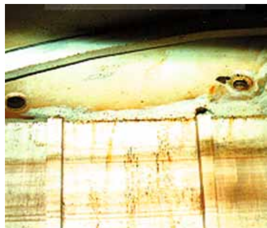
照片24.6 排污缸内已变形的加强板
