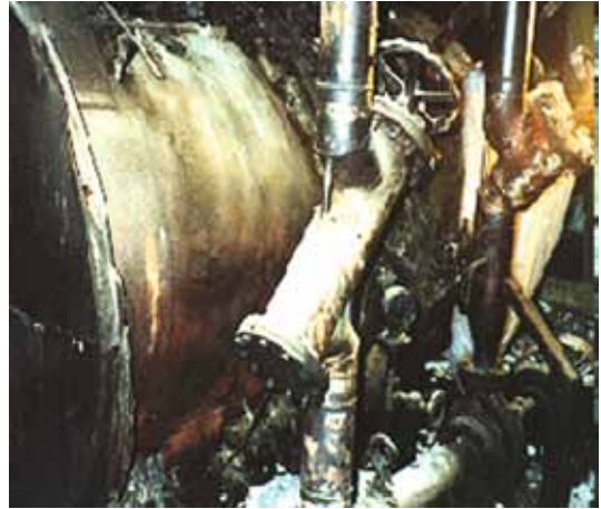
照片22.4 整个锅炉房遭严重焚毁
