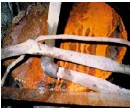
照片7.5 蒸汽歧管另一边的焊缝
