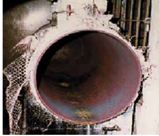
照片8.2 蒸汽歧管端视图
