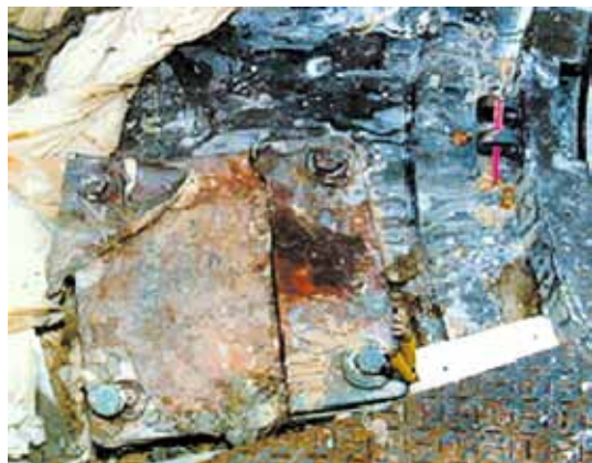
照片11.6 裂缝横跨铸铁托架的整块平底板
