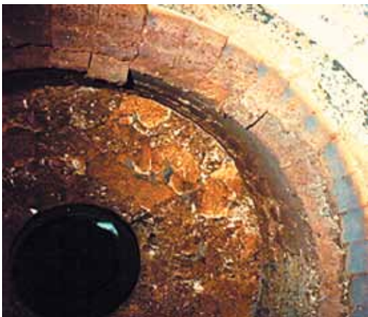
照片23.5 熔渣在炉膛顶积聚
