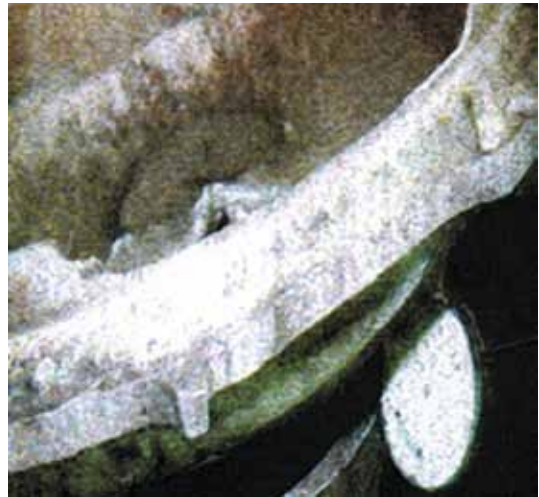
照片1.4 破裂的煲盖封环边
