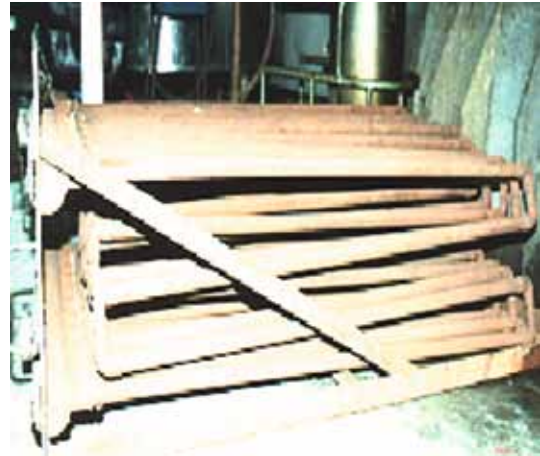
照片24.2 排污缸内的冷却盘管
