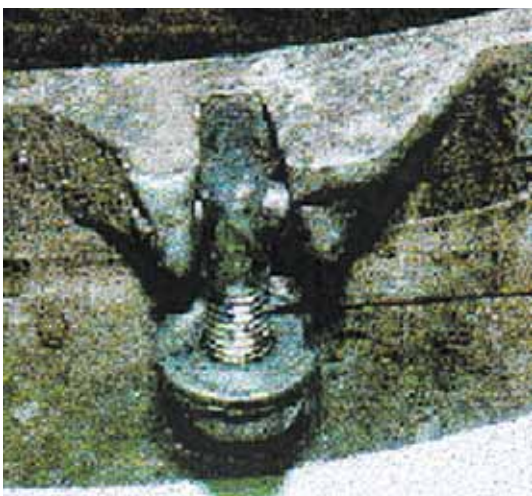
照片1.5 螺栓轴及紧锁螺栓
