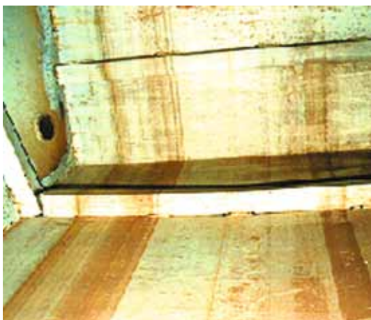
照片24.5 排污缸结构欠佳， 没有安装足够的加强板
