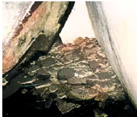
照片15.4 因爆炸而飞脱的尾端封盖和倒塌的耐火材料
