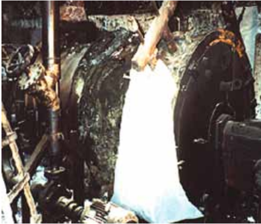
照片22.3 在循环泵的底部并无装设存漏池
