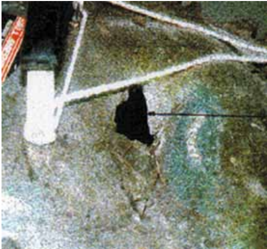
照片1.1 安全阀的洞口被弄穿
