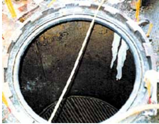
照片11.2 显示蒸汽洗涤缸内部的近距离图
