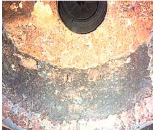
照片23.4 炉膛耐火层被烧毁
