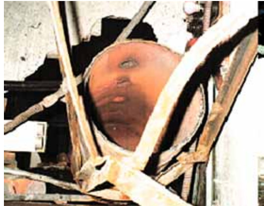
照片7.2 蒸汽歧管的端视图
