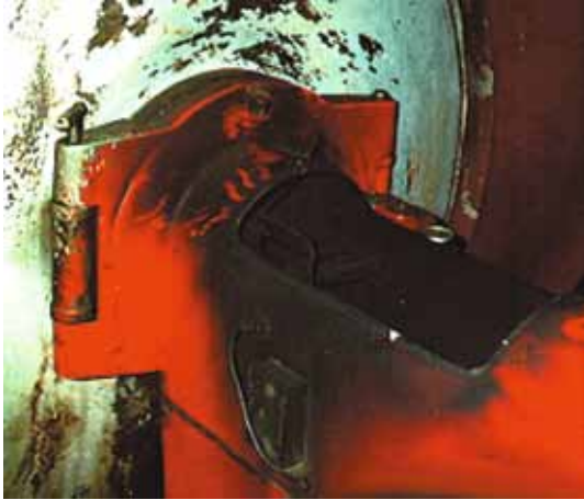
照片23.1 燃烧器组件被烧毁和熏黑
