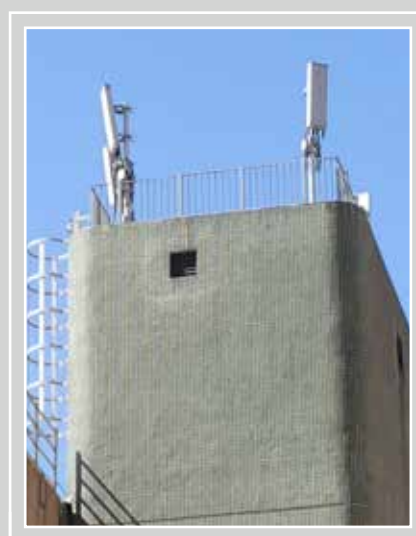
天台邊緣的永久欄杆
