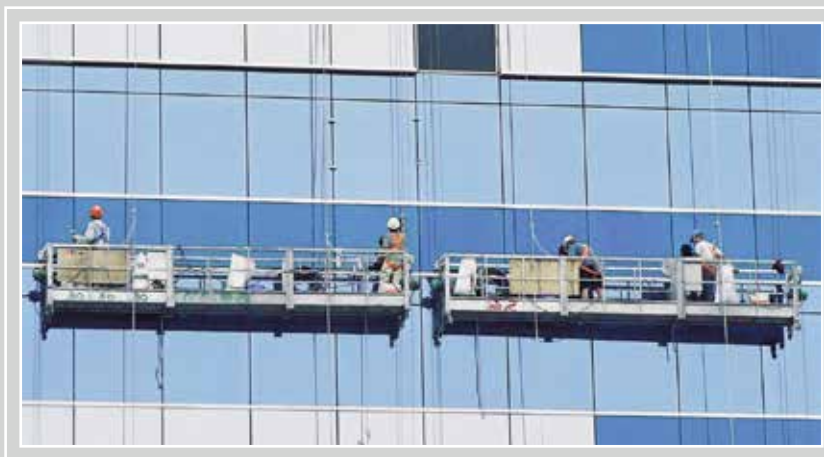
工人在吊船 維修 / 清潔 幕牆
