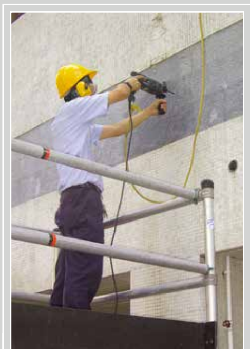
用掛繩以防止使用中的工具從高處墮下
