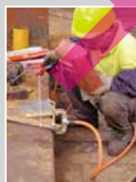
使用易燃物品時， 須提供適當的防火及 滅火儀器，並禁止進行 明火工序及吸煙
