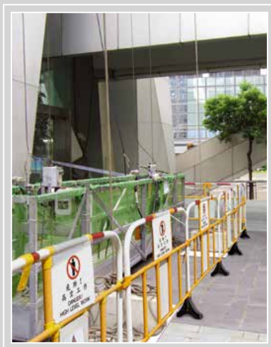
以混凝土壓重物把為在吊船 工作的工人而設的獨立救生繩 下端固定在地面
