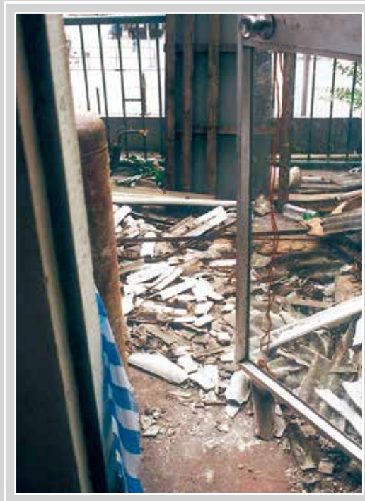
每當含有石棉的物料被破壞或打碎時， 都會產生大量石棉塵。
