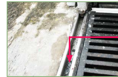
檢查閘門地面軌道的情況及平直程度， 並清除積聚在軌道內的雜物，以免對閘門造成震盪或阻礙其正常運作
