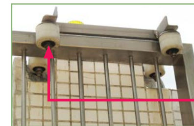
檢查閘門的導輪及滾軸的磨損程度
