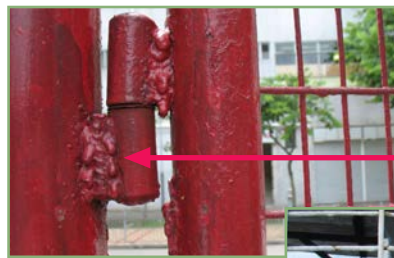
閘門的鉸鏈、軸心由於長期運作和使用，以及過度的擺動導致軸心變形及彎曲
