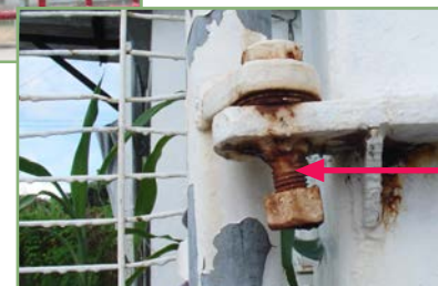
閘門的鉸鏈、軸心由於長期運作和使用，以及過度的擺動導致軸心變形及彎曲
