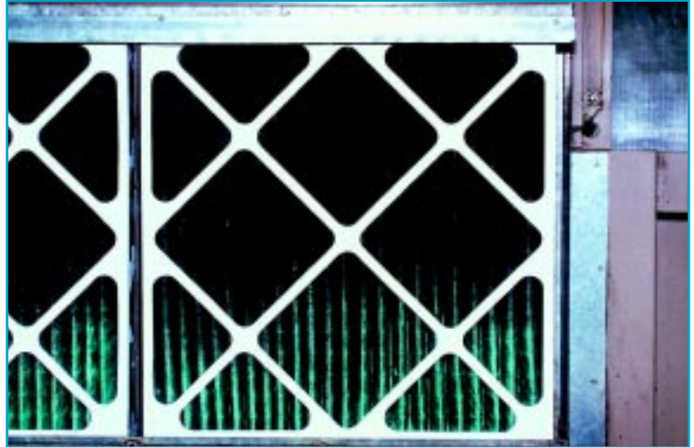
霉菌在污穢的隔塵網生長情況
