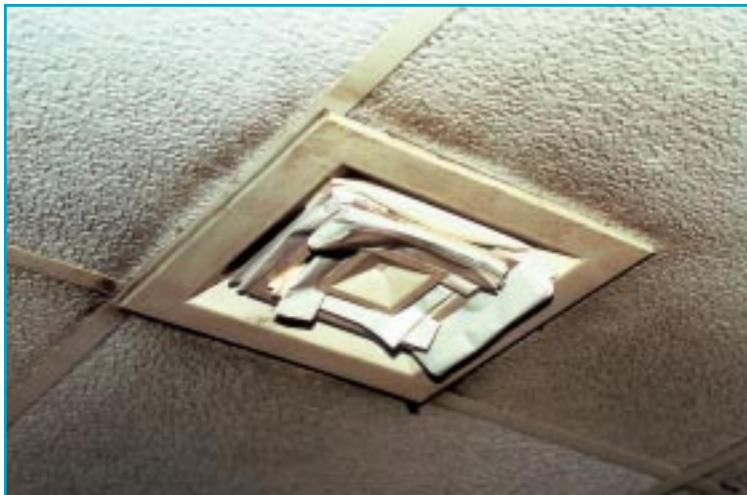
不均衡的通風可能干擾室內的溫度和供氣，阻礙出風口可能使供氣更加不平均
