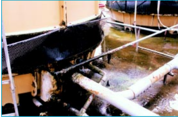
保養差的系統可能成為微生物的滋生溫床
