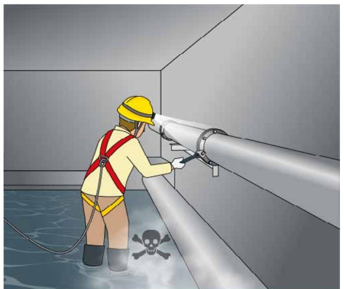
6. 忽視在通風不足的環境下進行渠務工作的危險
