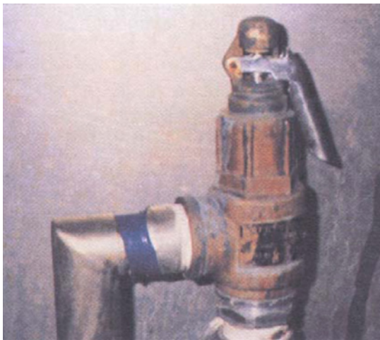
照片6.4 安全閥的封條不見了
