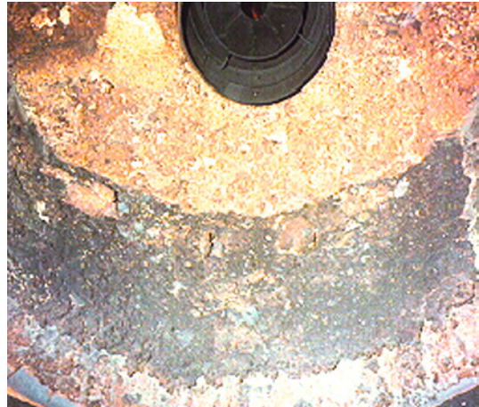
照片23.4 爐膛耐火層被燒毀
