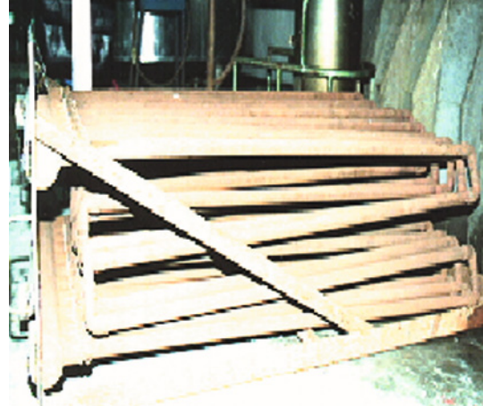
照片24.2 排污缸內的冷卻盤管
