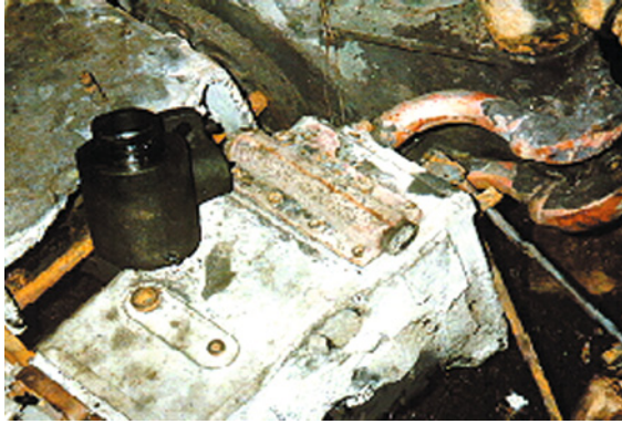
照片4.1 燒毀的燃燒器裝置
