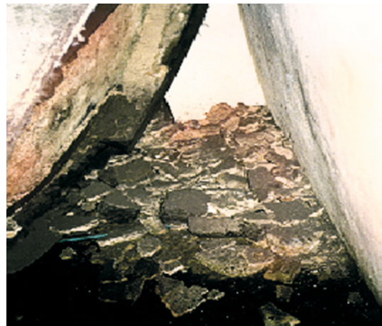
照片15.4 因爆炸而飛脫的尾端封蓋和倒塌的耐火材料
