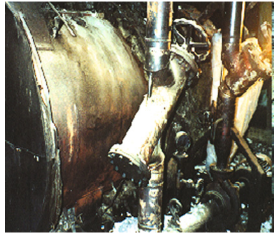
照片22.4 整個鍋爐房遭嚴重焚毀
