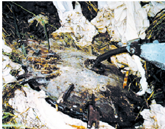
照片11.4 洗滌缸蓋的起重軸彎曲
