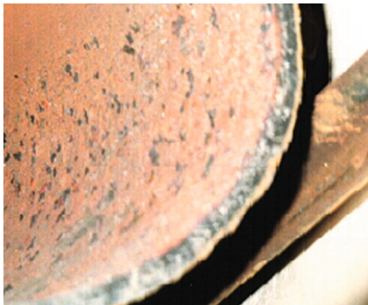
照片7.3 顯示蒸汽歧管的爆裂邊緣的近距離圖
