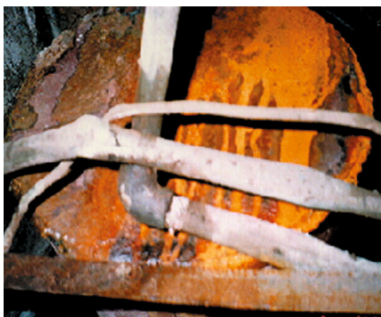
照片7.5 蒸汽歧管另一邊的焊縫
