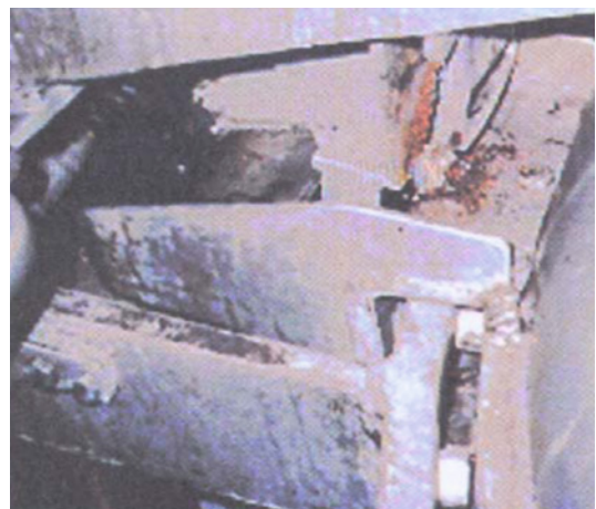
照片13.6 損壞的水位顯示器、 損壞的導桿及其托架
