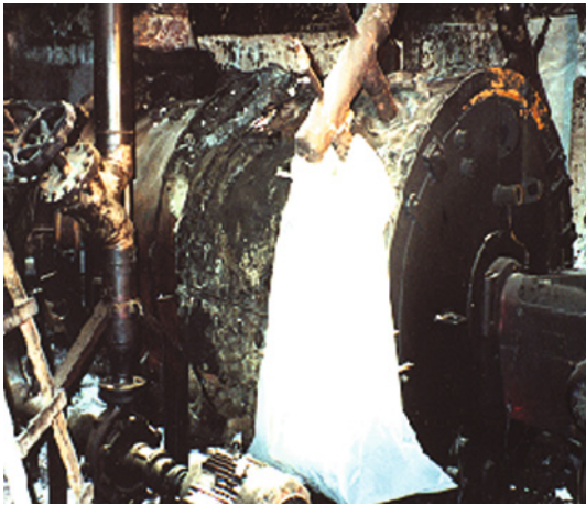
照片22.3 在循環泵的底部並無裝設存漏池
