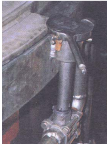
照片6.2 聯鎖排氣閥在關閉的位置上
