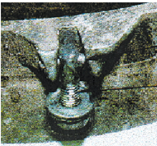
照片1.5 螺栓軸及緊鎖螺栓
