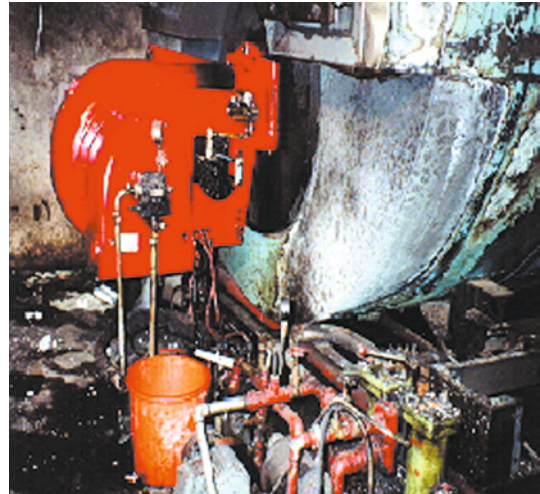
照片5.2 鍋爐及燃油系統的損毀情況
