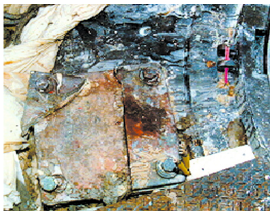
照片11.6 裂縫橫跨鑄鐵托架的整塊平底板
