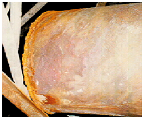
照片7.6 蒸汽歧管另一邊的端板的端視圖
