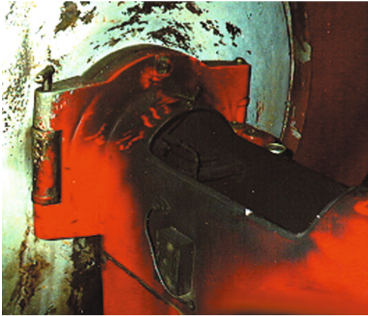
照片23.1 燃燒器組件被燒毀和燻黑
