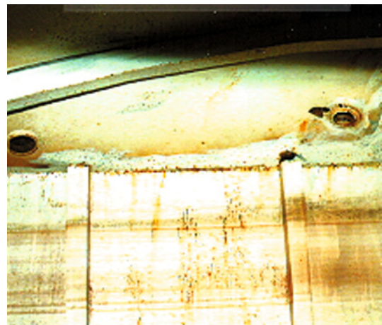
照片24.6 排污缸內已變形的加強板
