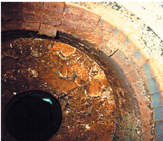
照片23.5 熔渣在爐膛頂積聚
