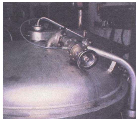
照片6.5 缸蓋上的氣動溢流閥
