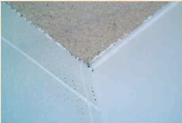
拆除隔音批盪
