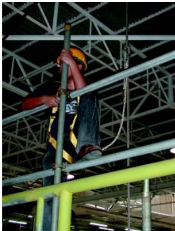
Photo 5 - metal scaffolding e r e c t i o n / d i s m a n t l i n g u s i n g r o p e c h u c k a n d v e r t i c a l i n d e p e n d e n t l i f e l i n e
