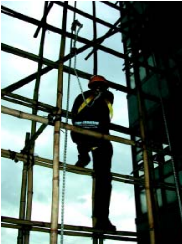
Photo 4 - bamboo scaffolding e r e c t i o n / d i s m a n t l i n g u s i n g r o p e c h u c k a n d v e r t i c a l i n d e p e n d e n t l i f e l i n e
