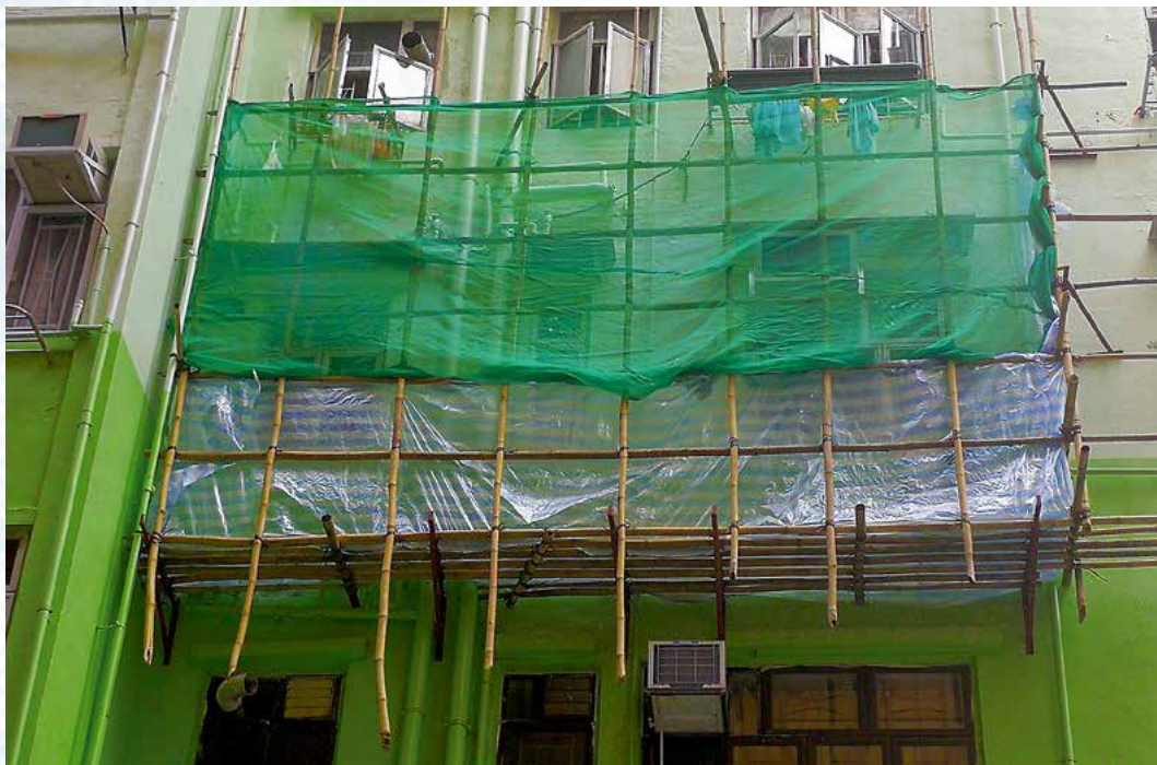
图 1 - 一般悬空式竹棚架
