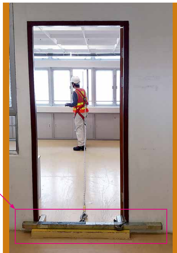
图 9 – 流动式临时防堕系稳装置的例子
