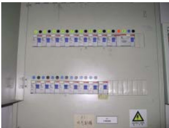
电箱的断路器(MCB)和水气掣 (RCD)设备
