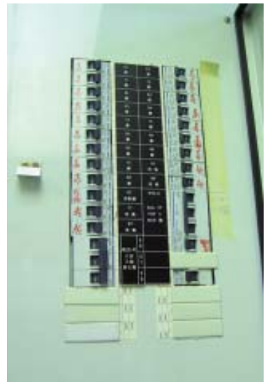
电箱的断路器(MCB)和水气掣 (RCD)设备
