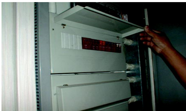
进行电力装置工作前应先截断及隔离电源
