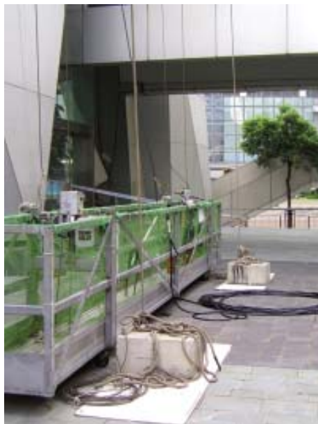
吊船工人使用的独立救生绳尾端在地面以石矢趺锚定
