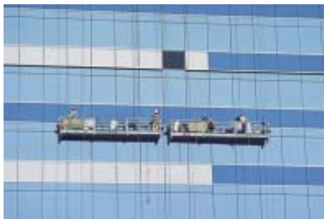
吊船在大厦外墙进行维修/清洁
