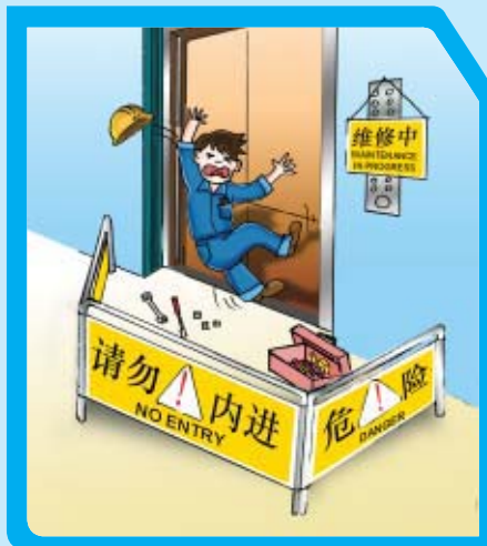
从打开的外门跌落升降机槽内
