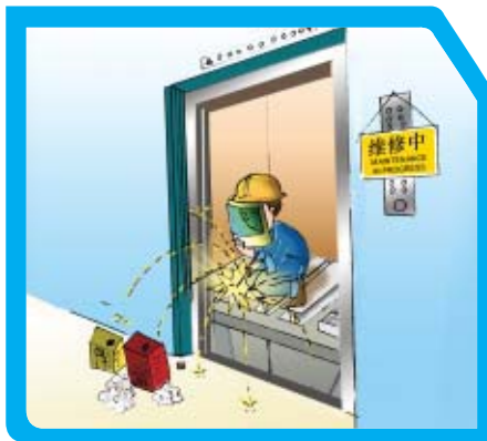
在易燃物品附近进行烧焊工序
