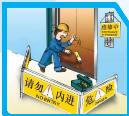
物体从打开的外门掉进机槽内
