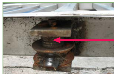
闸门底部装置的滑轮出现生锈，导致不能转动
