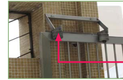
确保闸门导轮的数目与闸门的阔度及位置相配
