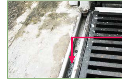
检查闸门地面轨道的情况及平直程度，并清除积聚在轨道内的杂物，以免对闸门造成震荡或阻碍其正常运作
