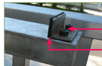
以螺栓及焊接方法固定防止闸门过度拉出的栓子
