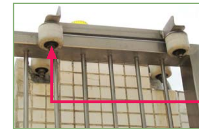
检查闸门的导轮及滚轴的磨损程度
