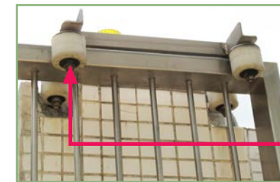
检查闸门的导轮及滚轴的磨损程度
