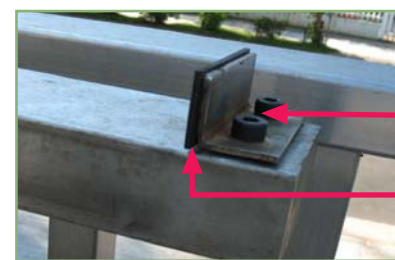
以螺栓及焊接方法固定防止闸门过度拉出的栓子
