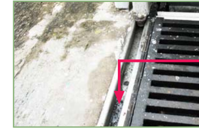
检查闸门地面轨道的情况及平直程度，并清除积聚在轨道内的杂物，以免对闸门造成震荡或阻碍其正常运作
