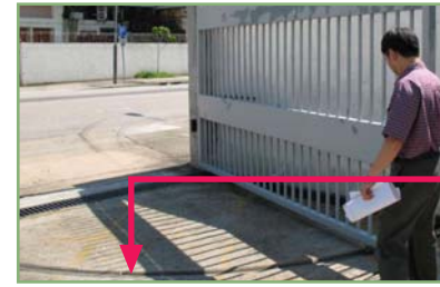
检查闸门地面轨道的情况及平直程度，并清除积聚在轨道内的杂物
