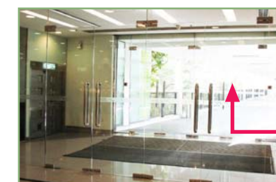
掩动式玻璃闸门，需以强化玻璃制造
