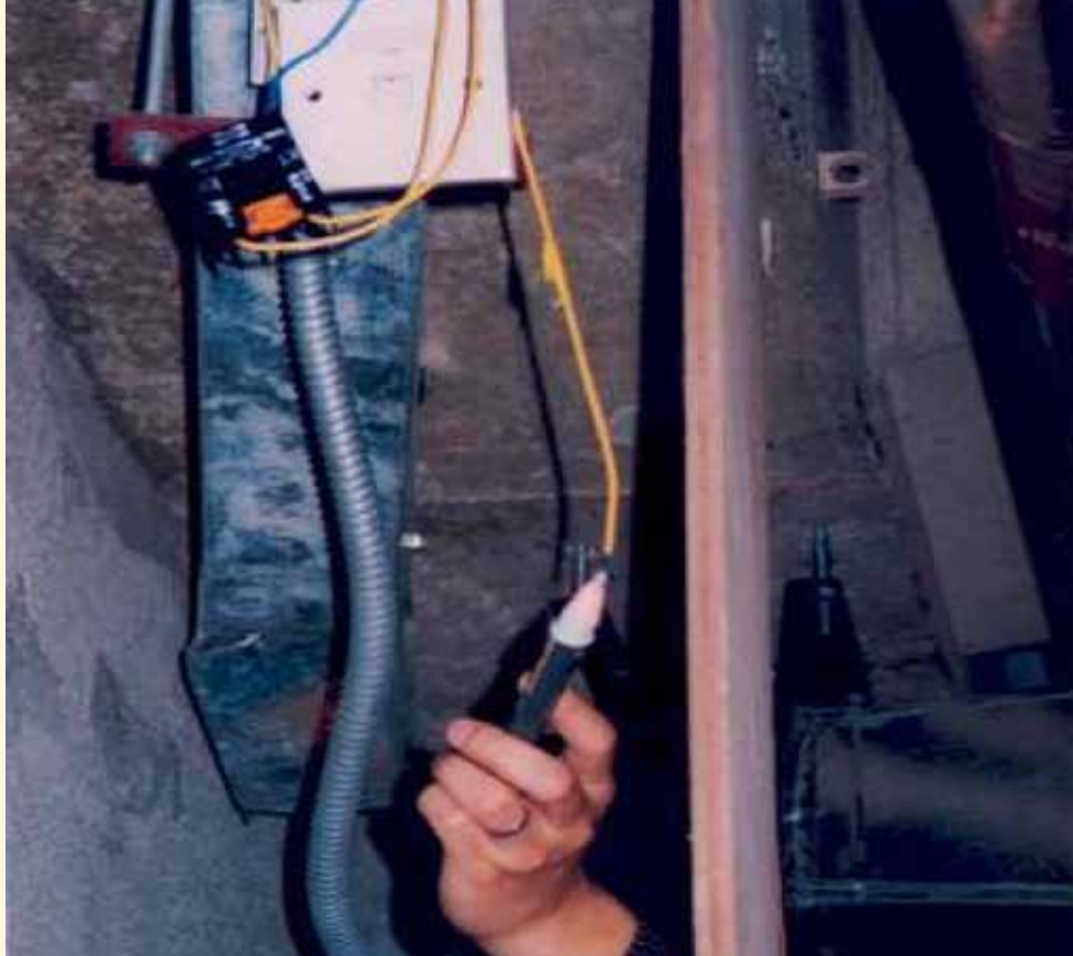
电线导体外露令工人有机会触及
