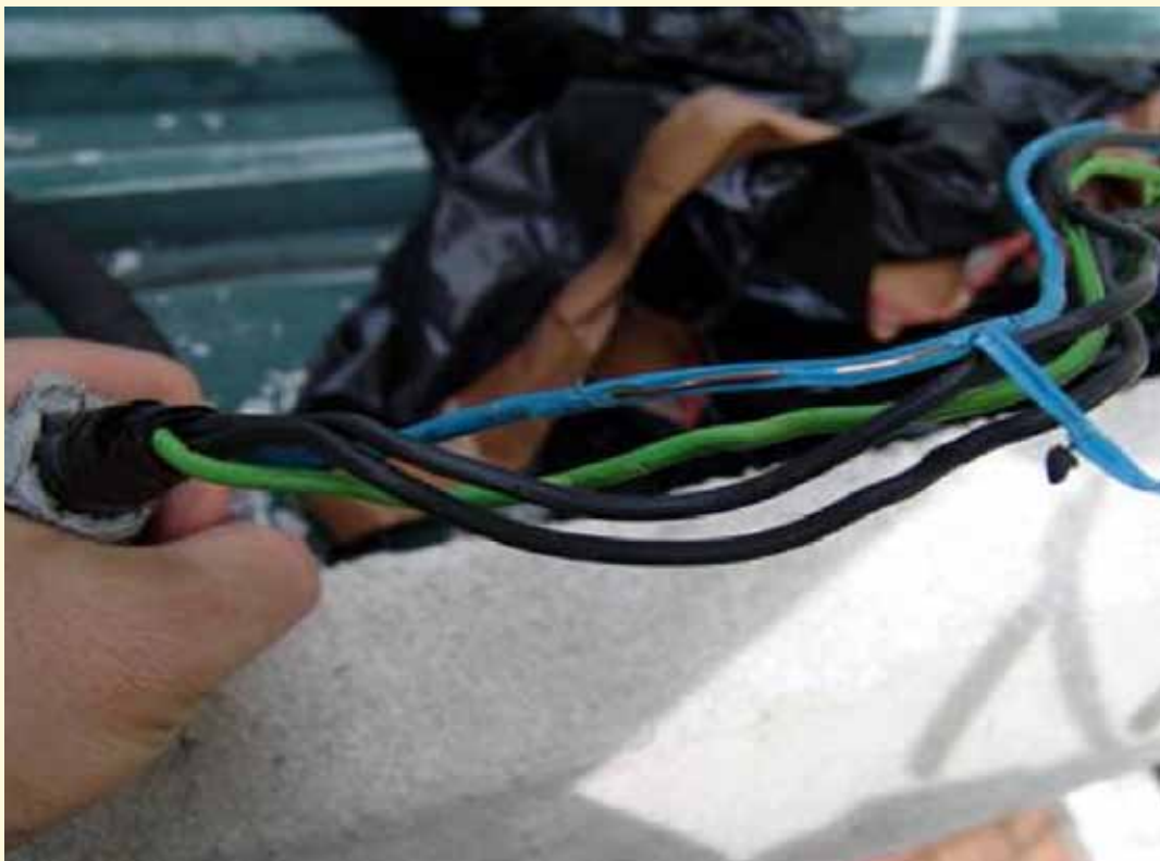
保护电线的胶皮因从金属孔口被扯出而受损，露出带电导体
