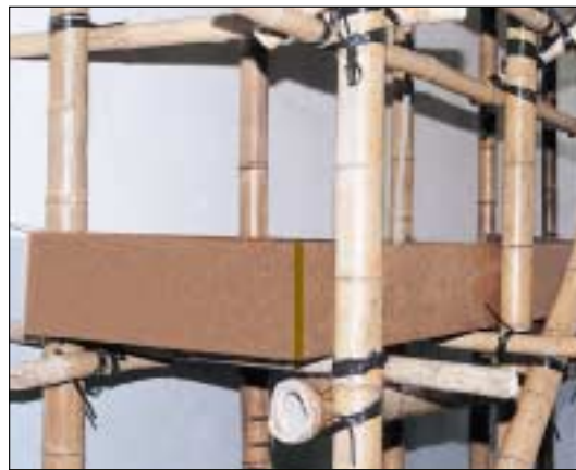
工作平台应以横竹作护栏、设有底护板及以木板铺密*。
