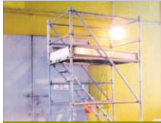
流动金属通架工作平台应设有护栏、底护板和上落爬梯*，并采取有效措施，以确保棚架的稳固性。
