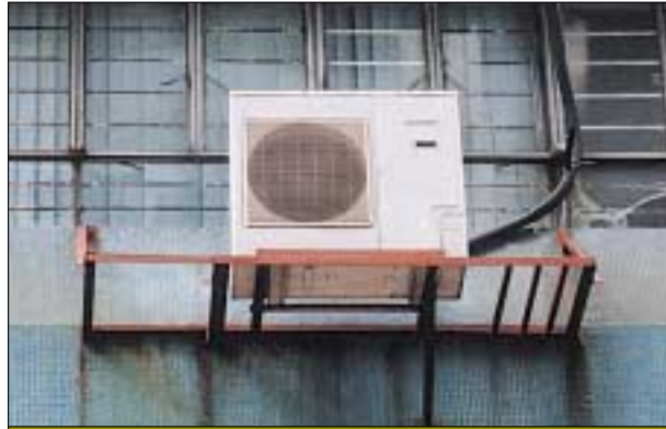
在外墙安装分体式冷气机是常见的高空工作。
