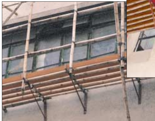
悬空式竹棚架应设有适当工作平台，其底部要有足够的支承架。
