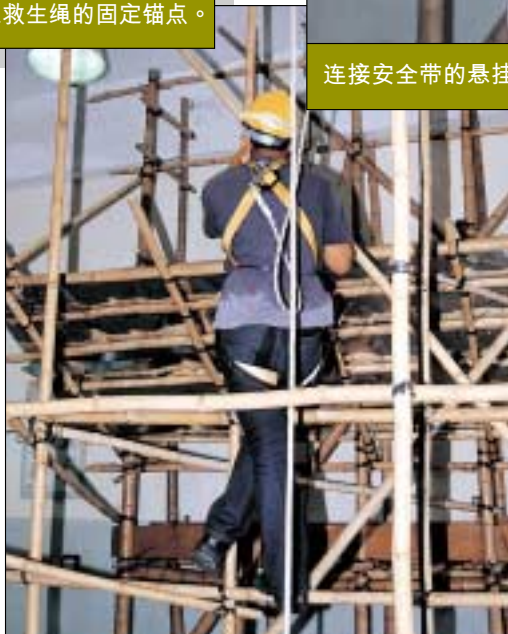
安全带必须紧系于可承受不少于5000牛顿拉力(约510公斤拉力)的固定锚点或独立救生绳上。
