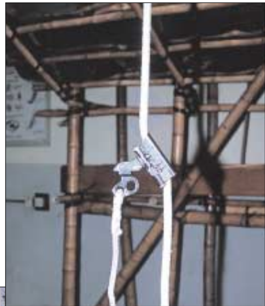
连接安全带的悬挂绳和独立救生绳的防堕器。
