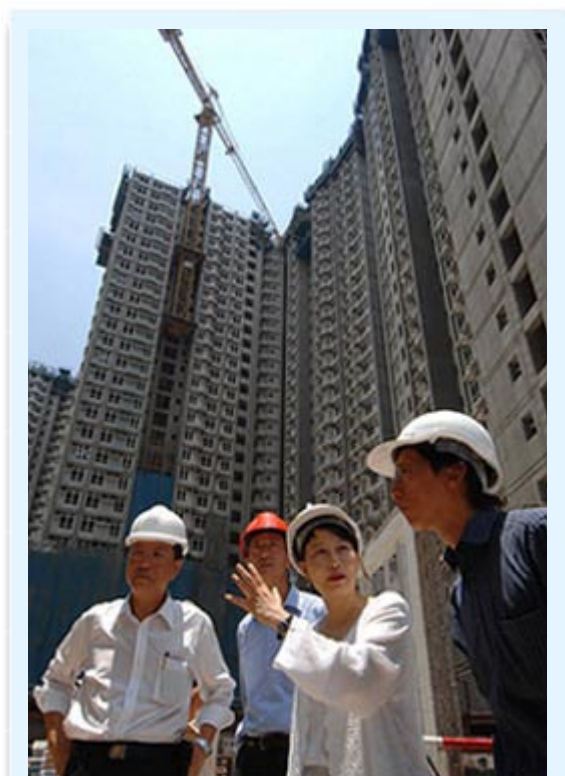
劳工处处长谢凌洁贞巡视建筑地盘，对塔式起重机的运作及安全措施表示关注。
