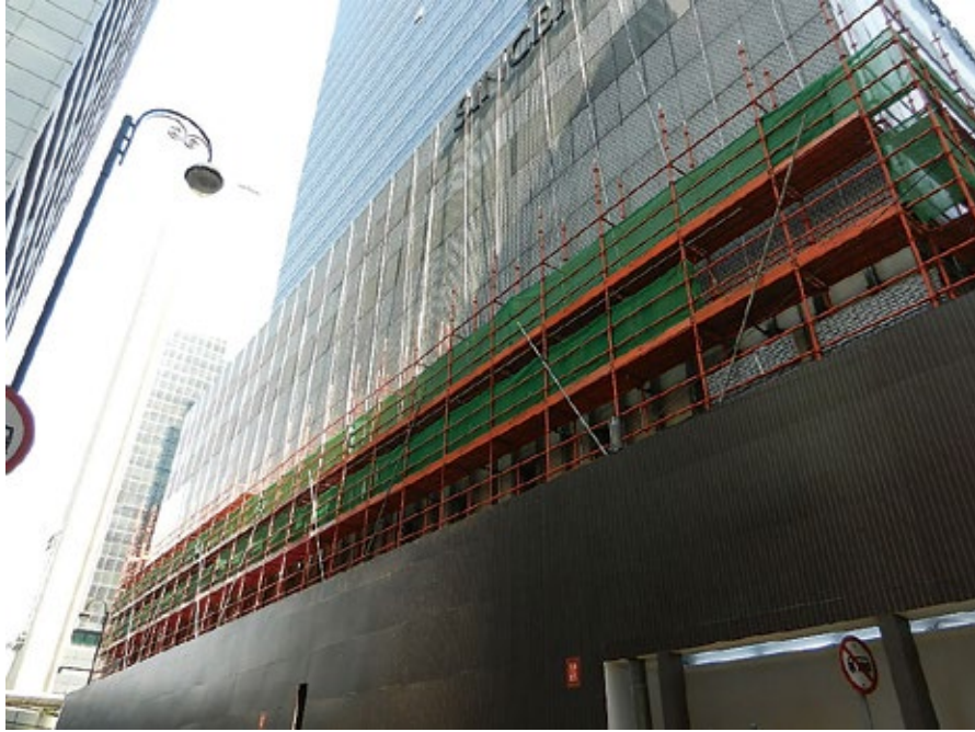
图 9：独立式金属棚架
