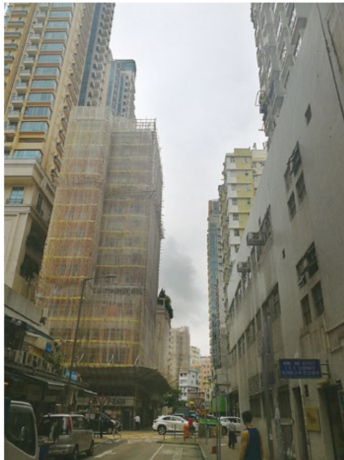
图 6：维修楼宇用的双行竹棚架
